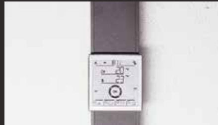
AUTOMATISCHE STEUERUNG automatisierte Regulierung von Beleuchtung, Beschattung, Heizung und Fenstern
